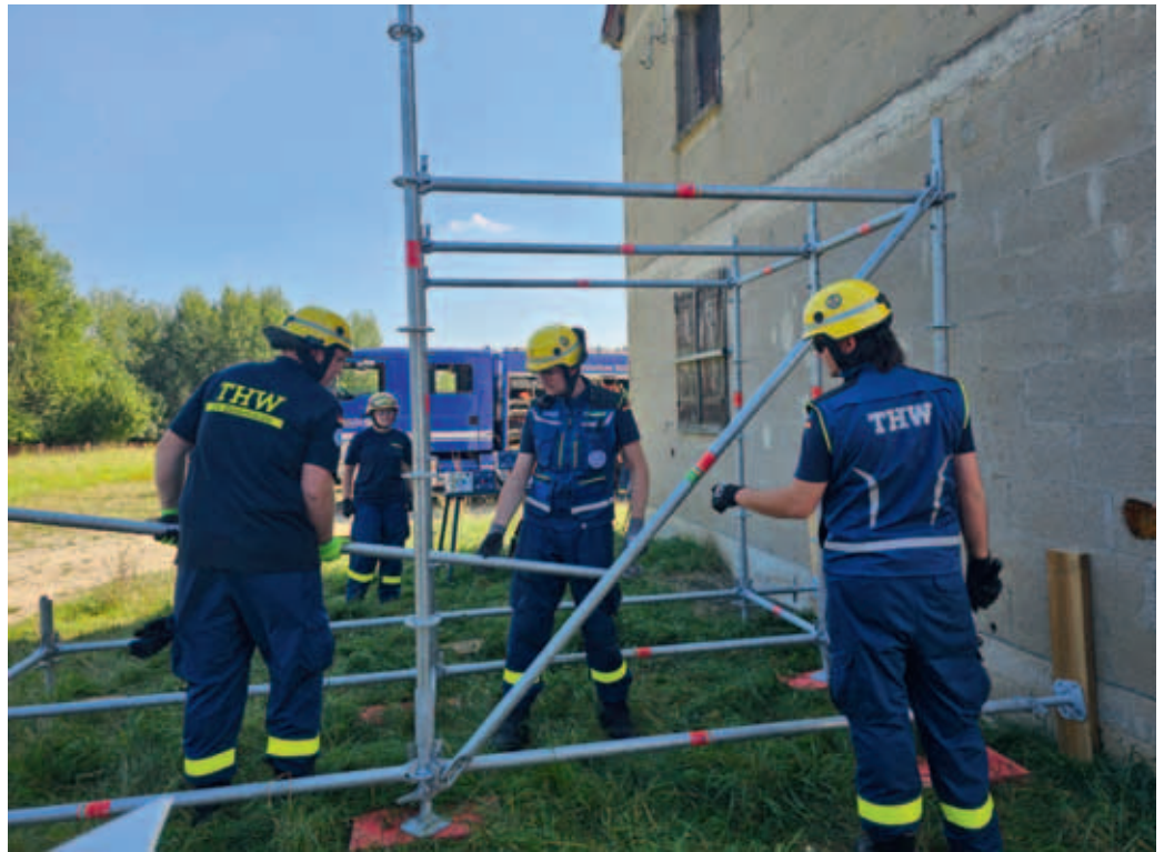
Gebäudesicherung - das bedeutet nicht nur Schutz vor einstürzenden Mauerteilen, das bedeutet auch Sicherheit für die Einsatzkräfte und die zu Rettenden.
