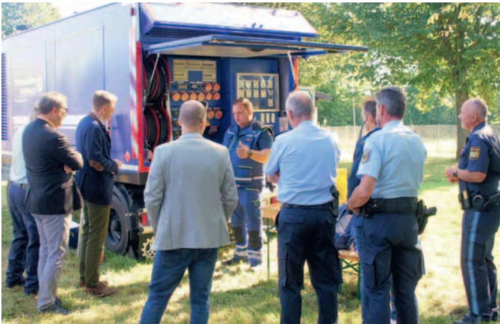
Hans Döring (Fachberater und Zugführer THW Hof) erklärt den Besuchern die Möglichkeiten der Fachgruppe Elektroversorgung an der Netzersatzanlage
