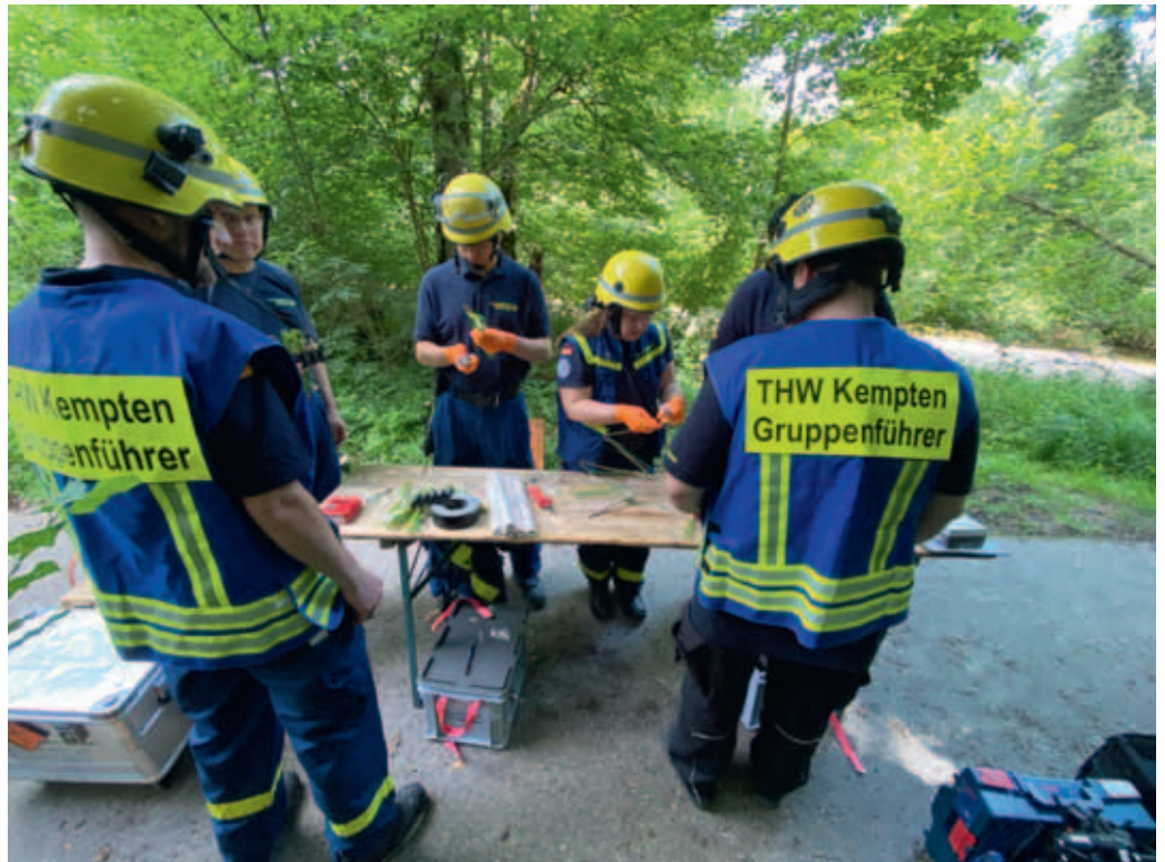
Sie bereiten die Sprengladung vor. Helfer v.l.n.r Vetter Bernhard, GrFü, FGr Sp, Markus Stempfel, Sprengberechtigter LV, Arne Rösch, FachHe FGr N, Carina Crombach, FachHe FGr F, Stephan Dallabetta, Sprengberechtigter FGr Sp,
