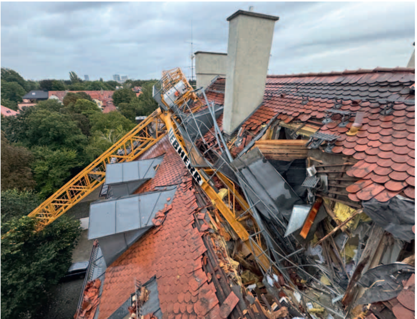
Acht Tonnen Gewicht zerstörten das Dach.
