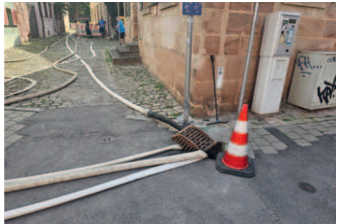
Über lange Schlauchstrecken wird das abgepumpte Wasser aus den Kellern in die Kanalisation befördert.
