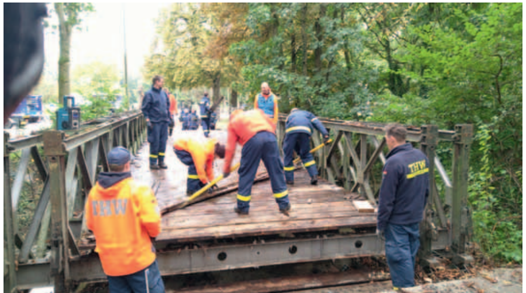
Da der Verschleißbelag sicher halten muss, wurde er bei der Montage mittels Druckluftnaglern auf die Traghölzer genagelt.
