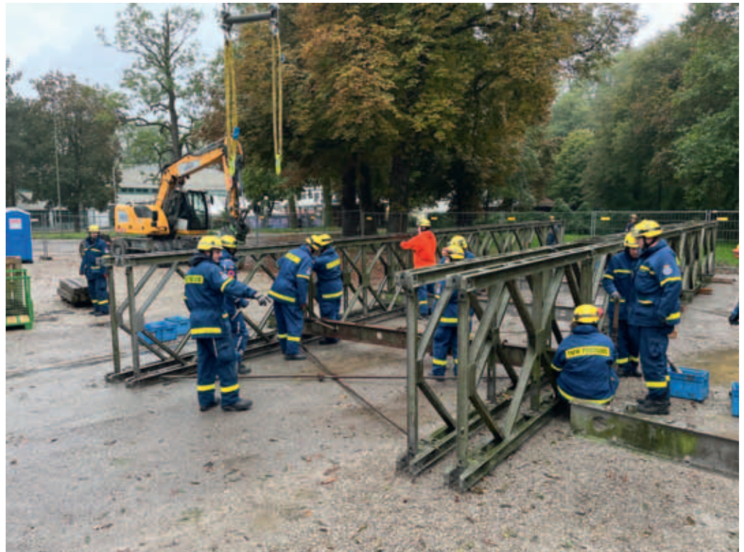
Abbau der Brücke nach dem Ausheben mittels Kran und Handarbeit durch die ehrenamtlichen Einsatzkräfte
