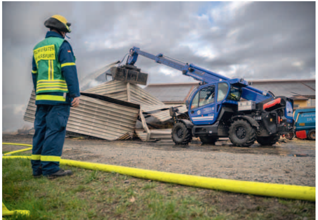
Das Dach des Unterstandes musste mit Hilfe des Teeladers eingerissen werden, um besser an die brennenden Strohballen heranzukommen.
