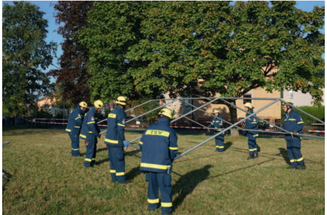
Aufbau eines SG300 Zeltgerüsts
