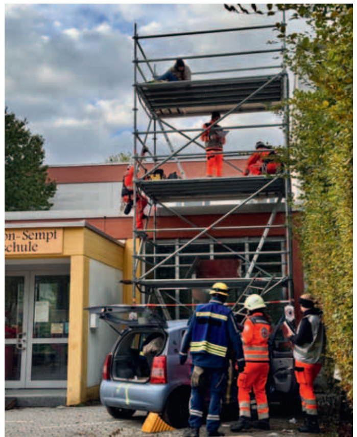
An der alten Grafen-von-Sempt Mittelschule in Markt Schwaben war ein PKW in ein Baugerüst gerast - ebenfalls eine vielfältige Übungsaufgabe.
