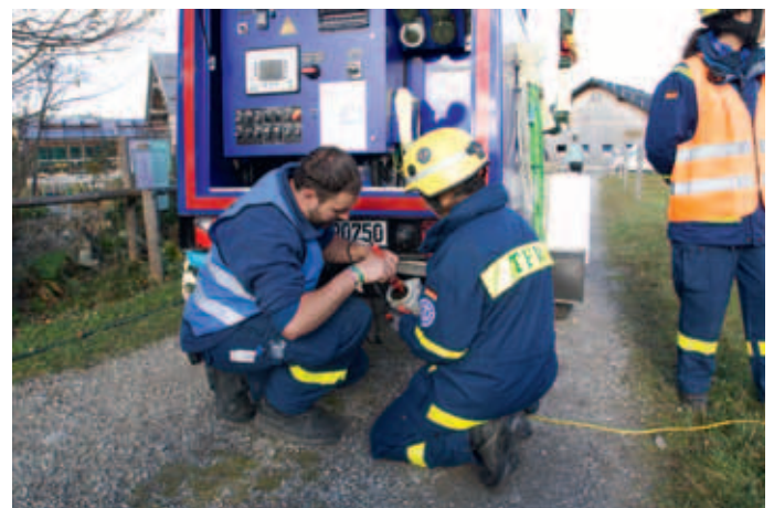
Der Helfer Felix Eller bereitet die Inbetriebnahme des Stromerzeugers vor und übernimmt die dafür notwendigen Messungen.
