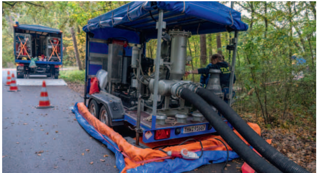
Mit der Schmutzwasserpumpe „Hannibal“ der Fachgruppe Wasserschaden/ Pumpen des Ortsverbandes wird das Löschwasser mit ca. 5000 Liter pro Minute in die vom THW vorbereiteten Wasserbecken gepumpt.
