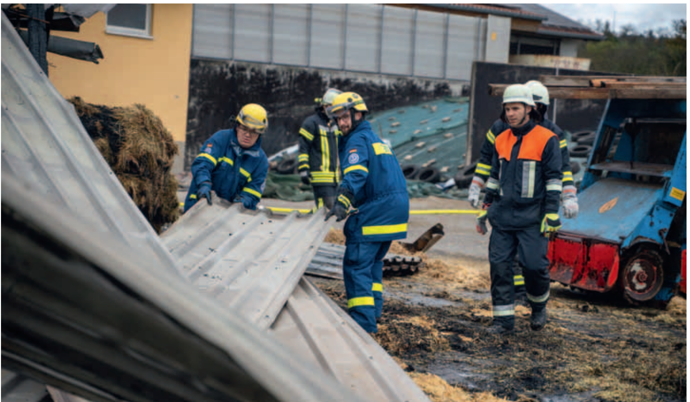
Manpower bei der Räumung des zerstörten Unterstandes.
