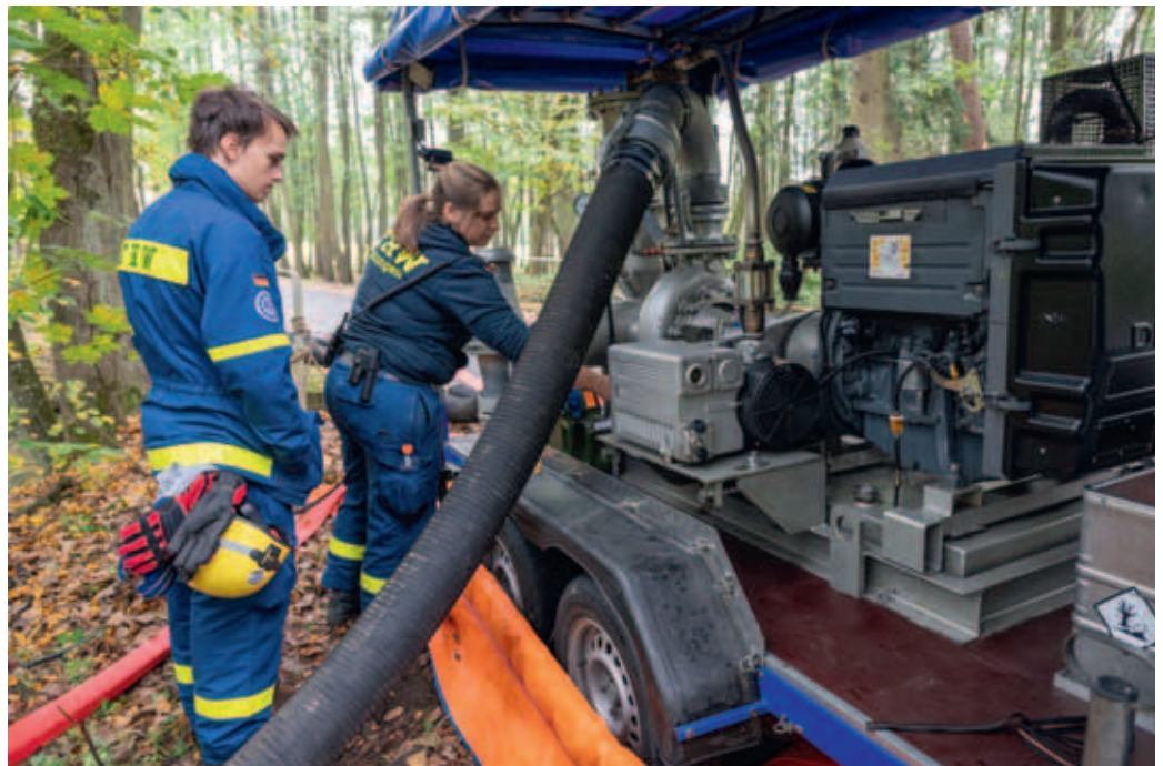
Über die Fähigkeit, leistungsstarke Pumpfähigkeit einzusetzen, verfügt das THW in großem Umfang.
