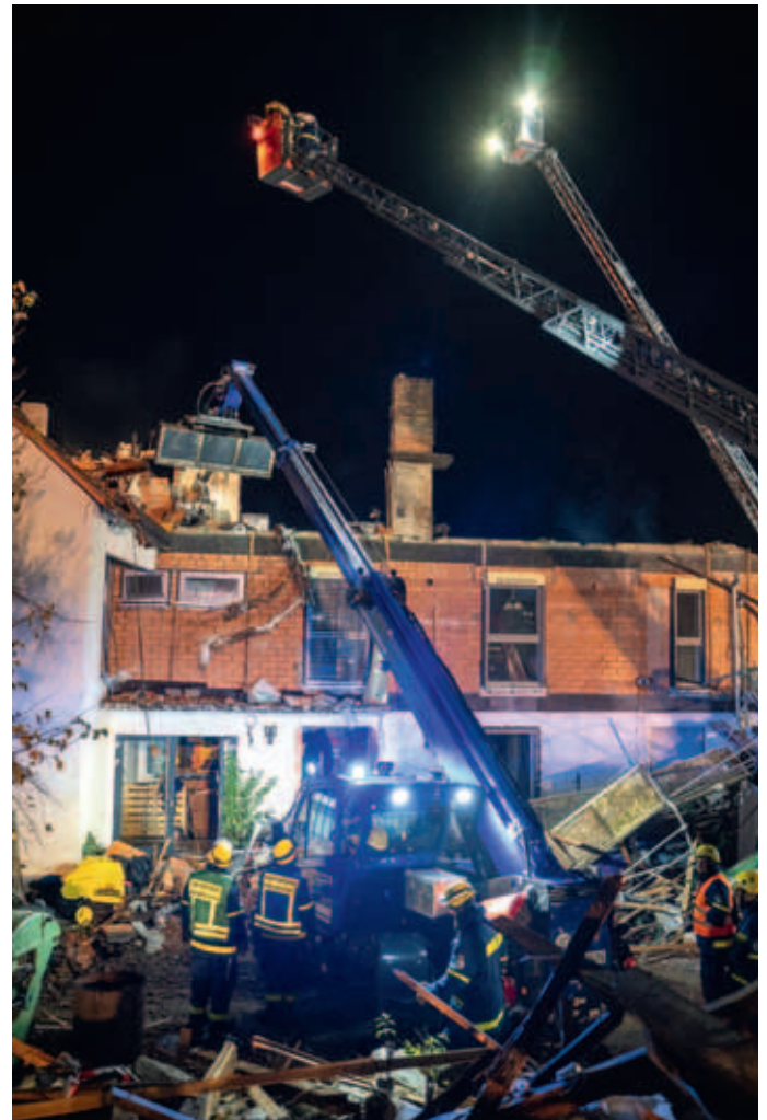
Lose Dachbalken und sonstige Trümmerteile wurden vom Teelader mit Niederhalteschaufel vom zerstörten Haus entfernt. Da das Gebäude nach der Explosion im Vollbrand stand, wurden zwei Drehleitern zeitgleich eingesetzt.
