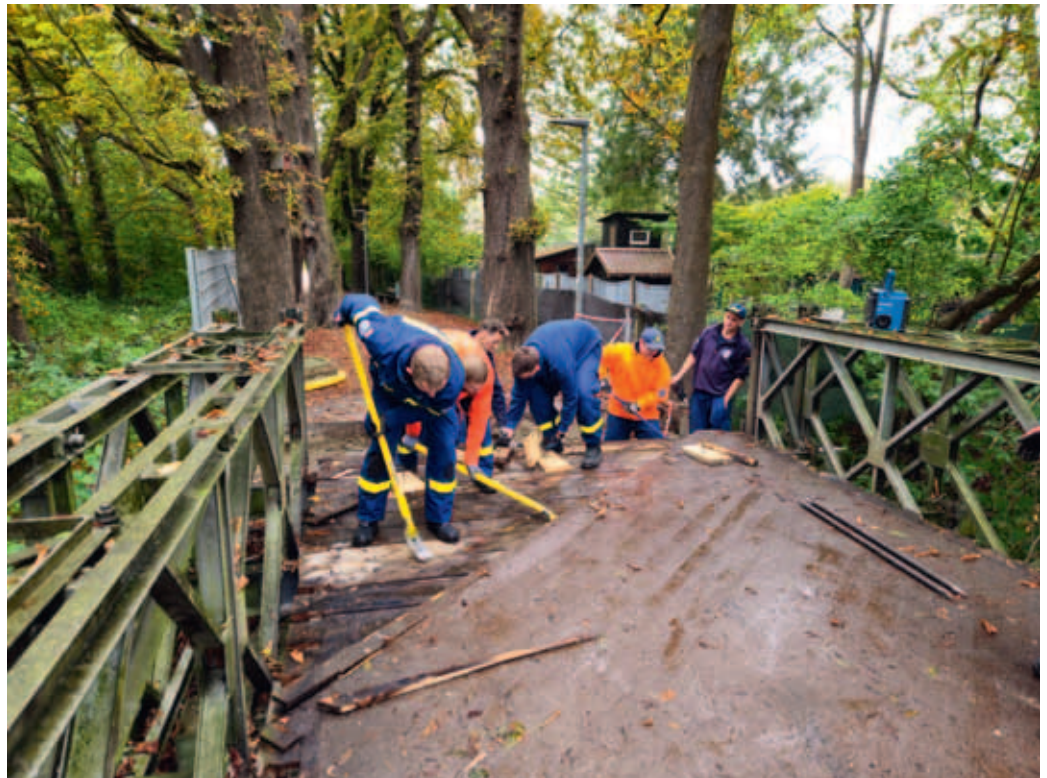
Mühsame und schweißtreibende Arbeit ist das Entfernen des diagonal auf die Traghölzer aufgenagelten Verschleißbelags.
