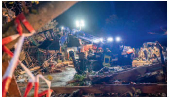
Mit der Niederhalteschaufel mussten um das Gebäude herum weit verstreute Trümmer geräumt werden.
