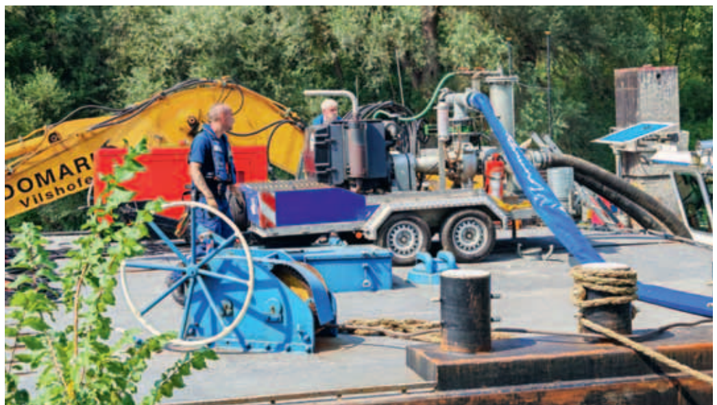
Die Pumpe wird an Deck des Schiffs in Betrieb genommen.
