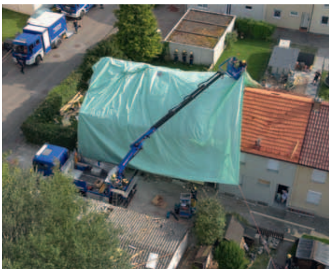
Ladekran beim Abdecken der Dächer
