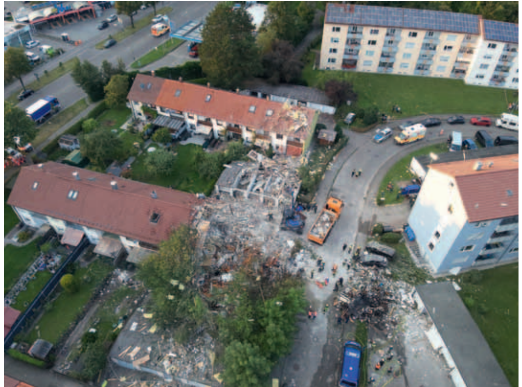
FG Räumen beim Abtragen von Randtrümmern, um den Weg zu möglichen Verschütteten zu ermöglichen.
