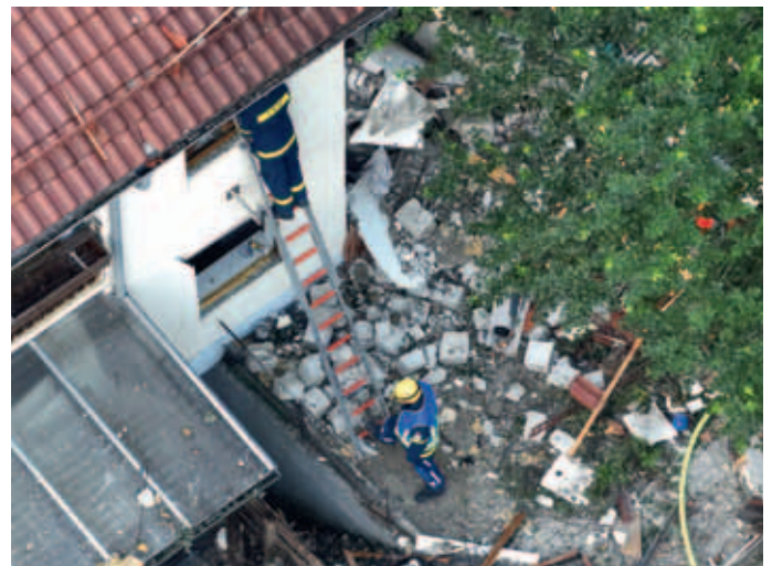
FG Ortung dringt mit technischem Ortungsgerät über eine Leiter in das 1. OG vor.
