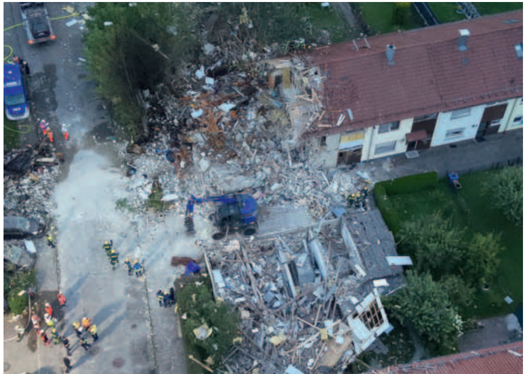
Mehrere Einheiten, darunter B, SB, R, O und UL vor Ort
