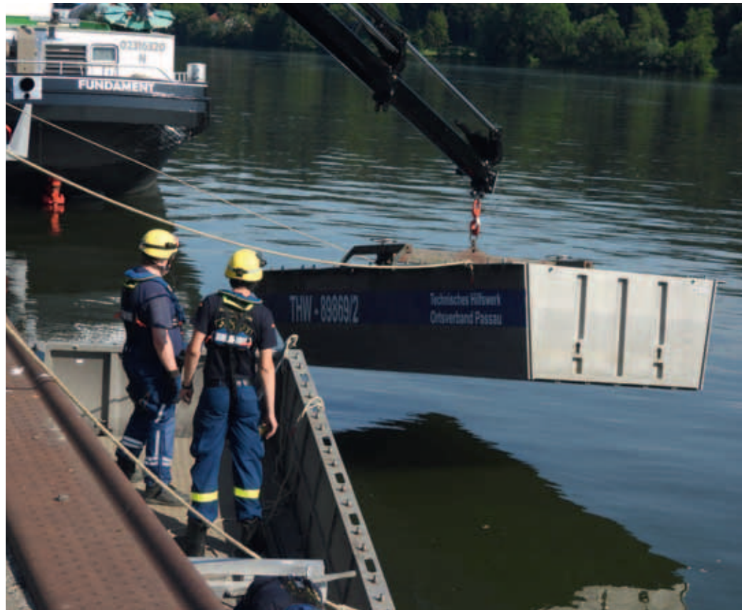
Stück für Stück müssen die Bauteile ins Wasser gehoben werden.
