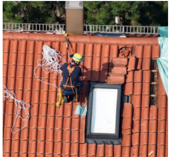
Arbeiten mit PSAgA auf den Dächern der umliegenden Häuser
