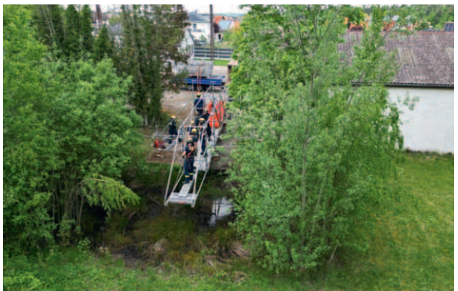
Links und oben: Errichtung des freitragenden Stegs mittels EGS.
