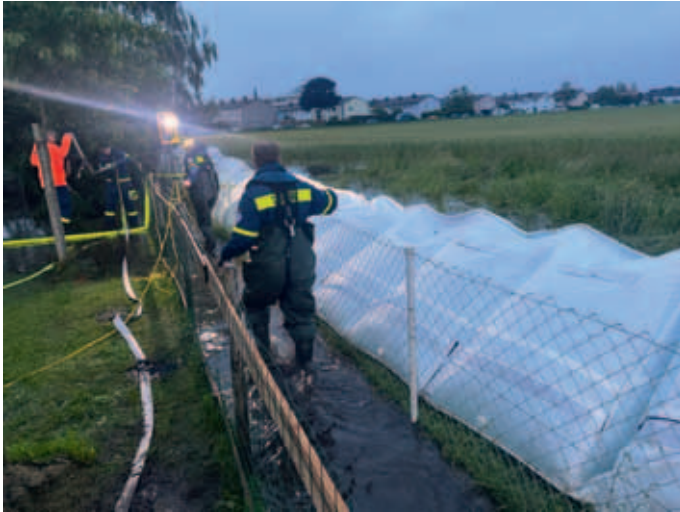
Ein Damm wird mit dem wasserbasierten Sandsackersatzsystem gesichert.
