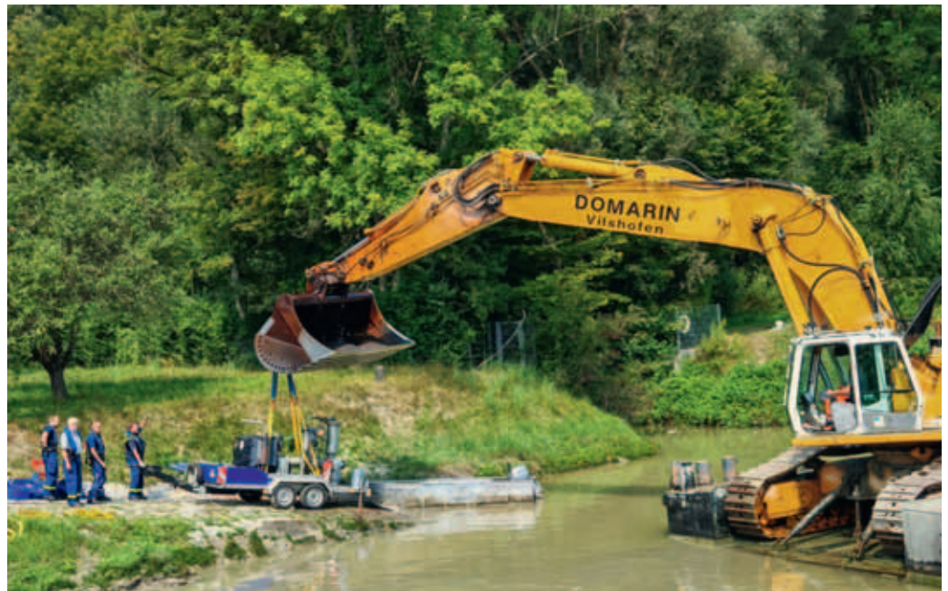
Die Schmutzwasserkreiselpumpe „Hannibal“ wird mithilfe von Seilschlingen an der Schaufel des Schwimmfähigen Baggers angebracht.
